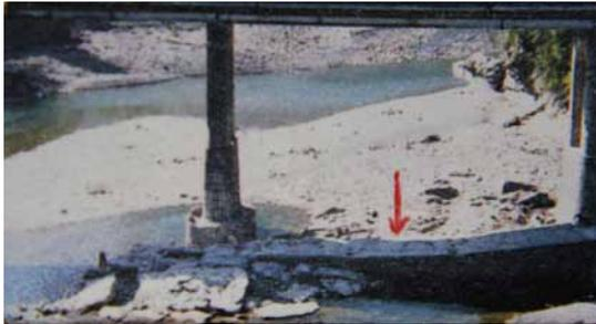
南勢溪在忠治村的加九寮段，有一條支流加九寮溪，溪中聳立著高高的水泥柱(圖6-1-7)，是早年輕便車(台車)道跨越溪谷的橋墩。日治時期日本三井合名會社為要把烏來山區的木材運往平地，而開築由平地通往烏來山區的台車路。起初跨溪的輕便車橋架設較低，形成輕微的坡度，載重的輕便車經過這裡時，往往需要兩位台車伏合力推車才能通過，如此來回兩台車互相幫助，要多費不少時間。後來龜山到信賢這段，改為行駛機動式的小火車(俗稱三分仔車)，鐵軌幅寬由1.8尺改為2尺寬，跨溪橋改建在舊橋的下游，橋墩升高，以鋼筋水泥建造。直到龜山通往信賢、桶後一帶的道路修築、方便卡車通行，載運木材的工作被卡車取代，烏來通往平地的台車軌道才被拆除，留下這橋墩遺址。
