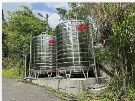
圖 二十五、運動場後方新增設的 2 座 10 噸蓄水塔
