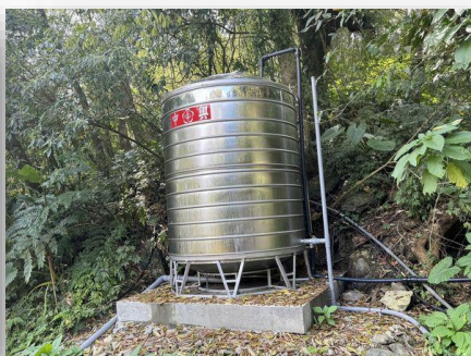
圖 二十六、野要街新設 1 座 10 噸蓄水塔，專供烏來里 11-12 鄰居民使用
